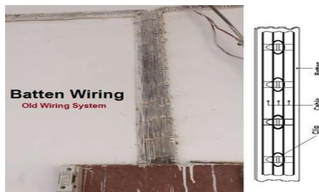
Fig.2.6. Batten Wiring.
